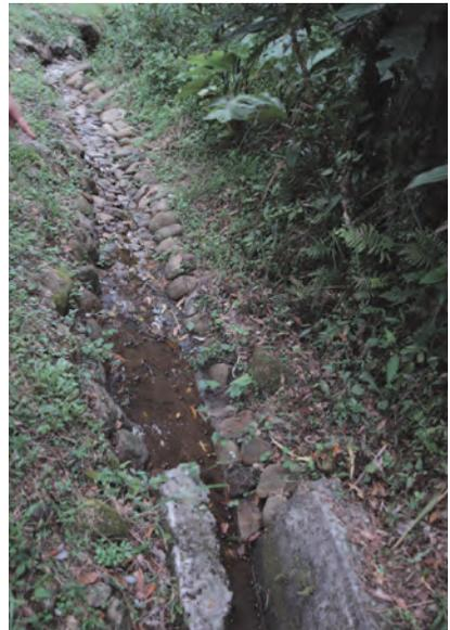
法鼓山佛學研究所位於金山鄉西勢溪上游旁，在2000年象神颱風時，因坡陡流急，兇猛的水勢造成了道路崩塌、溪床下切達2、3公尺深，也釀成下游房舍的嚴重災情。為了更貼近生態考量，法鼓山決定自行出資整治，負責施工的民間藝師謝福盛說，「師父當時有特別交代，盡量不要將溪水弄濁。」他因此採取逐段及左右岸輪流施工方式，利用土堤或石頭排成的臨時引水道，讓水中魚蝦可順著水勢從另一岸游往下游河段，而不會被施工中渾濁的砂泥窒息了呼吸。也因此，謝福盛說：「不到一年的時間，魚群甚至恢復得比施工前更多，較大尾的還有10幾、20公分長。」順著他的手指方向，除了苦花、溪哥等魚群就穿梭悠遊於石群間，在溪石固床工的後頭，還看到了兩隻毛蟹正歇息其間。不過謝福盛也表示，因為這種施工方式作業時間較長，公家單位或包商通常為了省錢或趕時間，未必願意採行。
