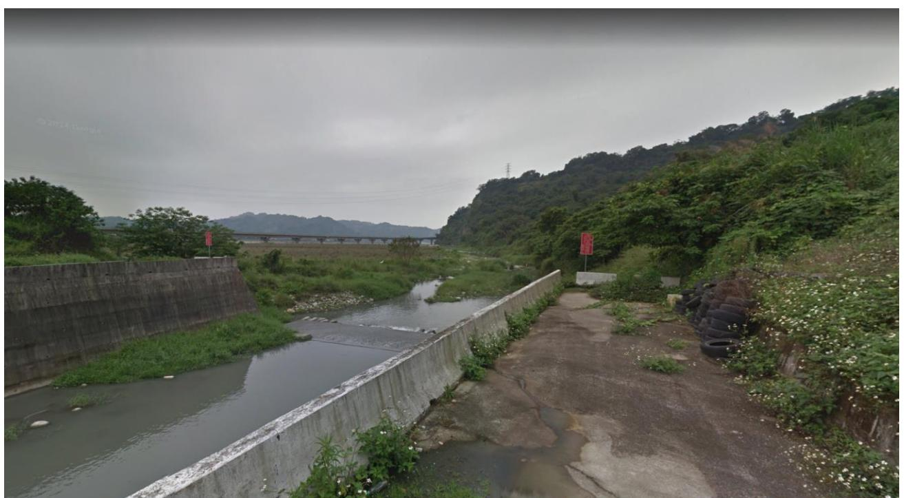
圖 19、老庄溪三面光工法石虎無法穿越(上圖)，下游匯入大安溪則仍舊保有一段自然溪流(下圖，取自 google 街景)
