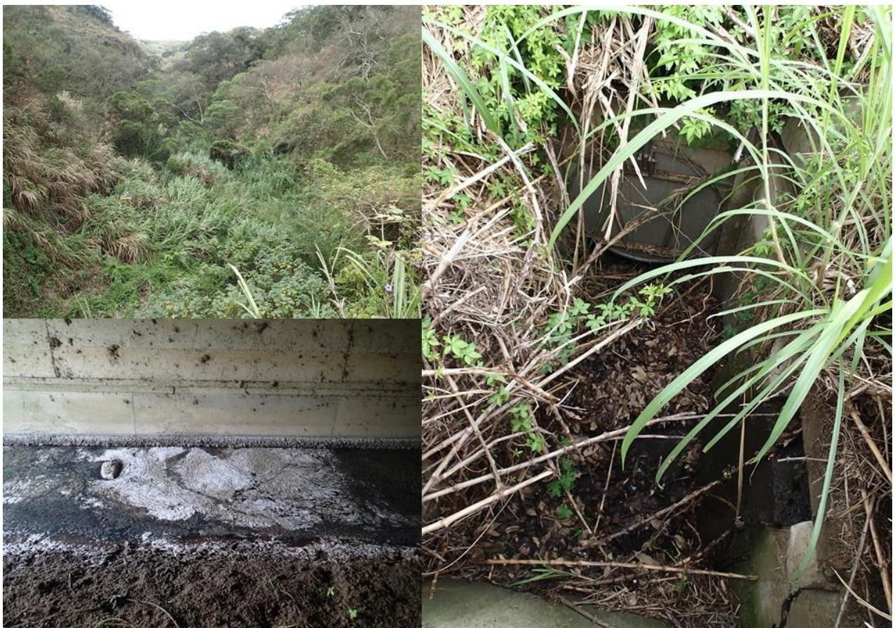
圖 46、涵洞與水閘門環境需適度營造。圖左上為涵洞 A 北側出口外植被密布情形。圖左下為涵洞 A 內水質惡化情形。圖右為 2.5 K 水閘門南側出口之落差情形。
