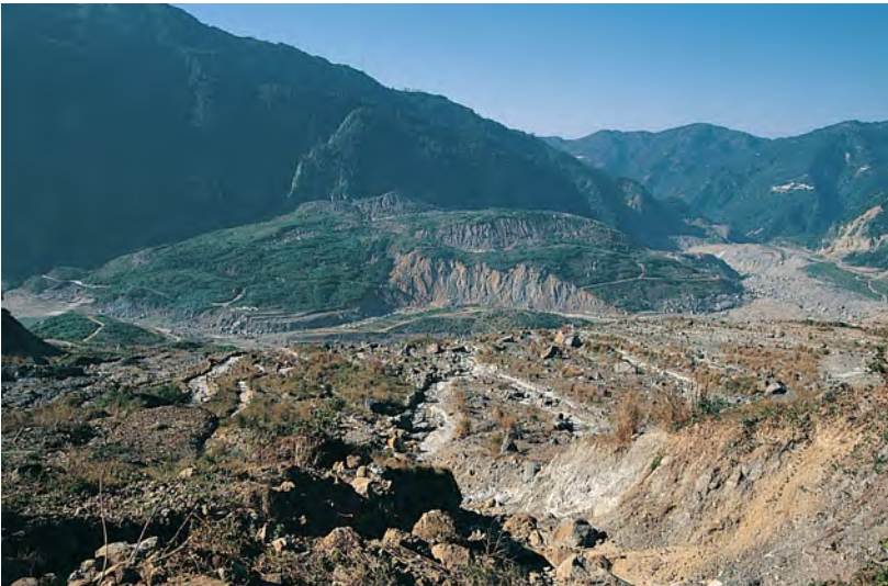
照片2 草嶺山崩大量的崩積物堆積於下方清水溪的河道上形成高約50公尺的天然土壩。
