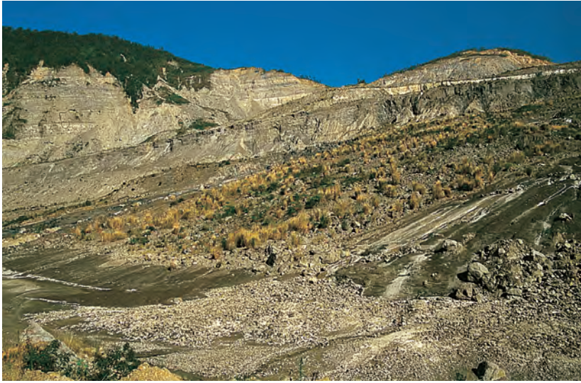
照片1 在921地震時草嶺山崩造成重大災害，當時的崩塌地大都為裸露的岩石。
