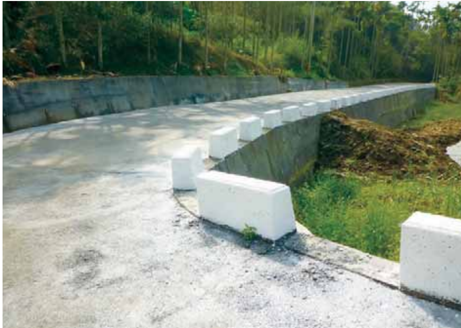
照片39 目前已修復921地震紀念地聯絡道路所損壞的路基
