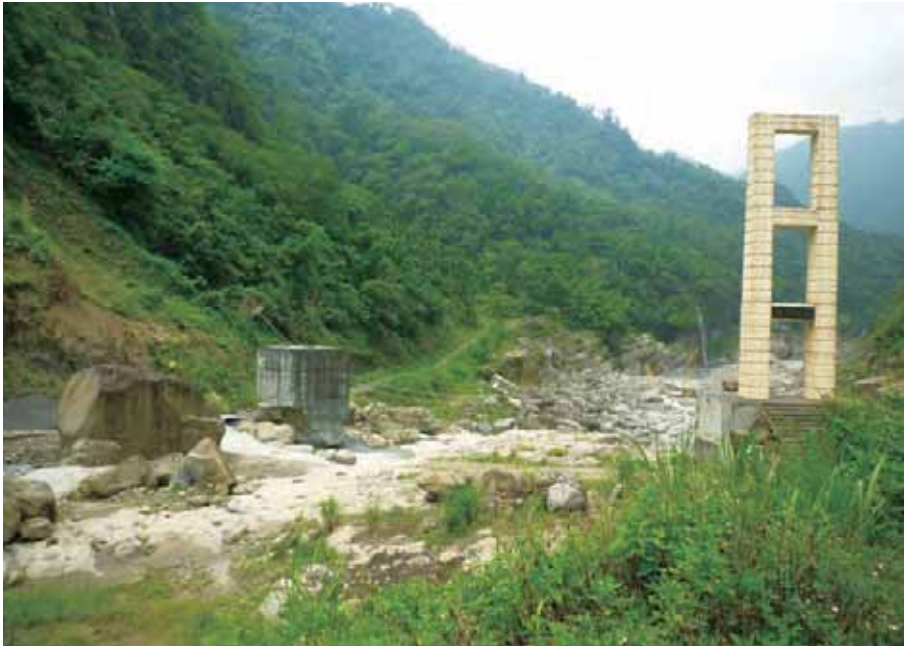
照片38 災後重建的內湖溪吊橋在2009年莫拉克颱風時被沖毀了
