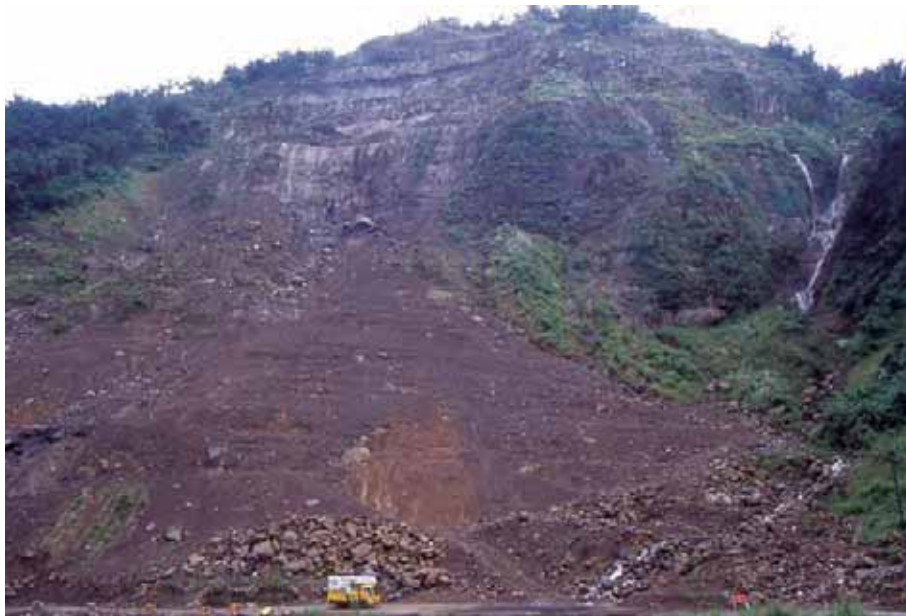
照片23 149乙公路牛乳科路段的崩塌地
