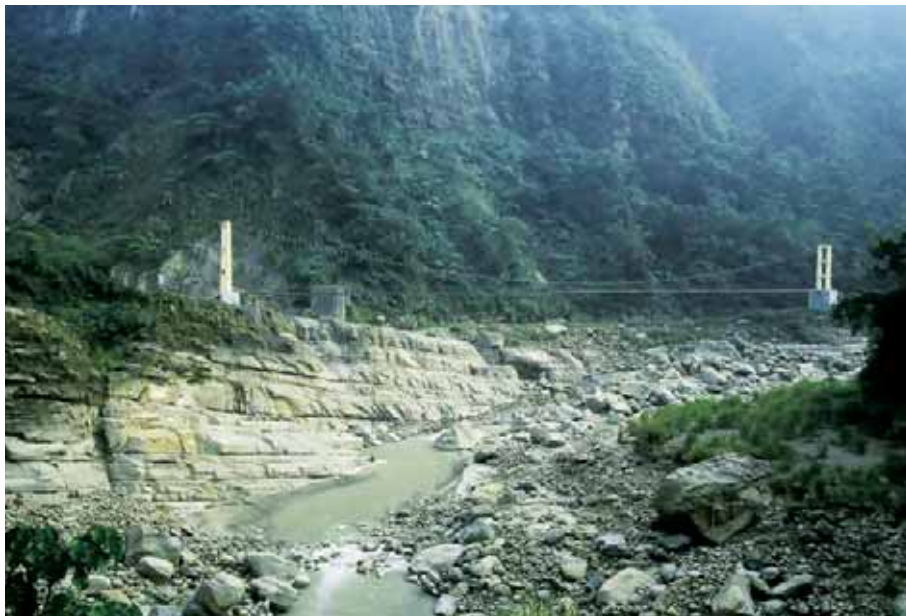
照片30 災後重建跨越內湖溪口的新吊橋
