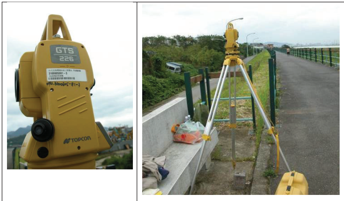
圖 5.3 全測站儀使用及操作情形
