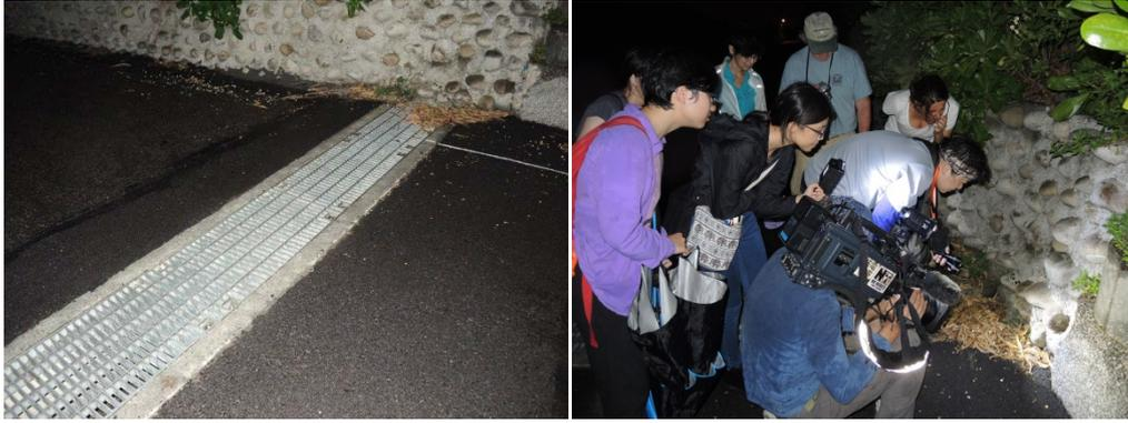
圖 4.2-12 河川局試作的蟹類動物通道
