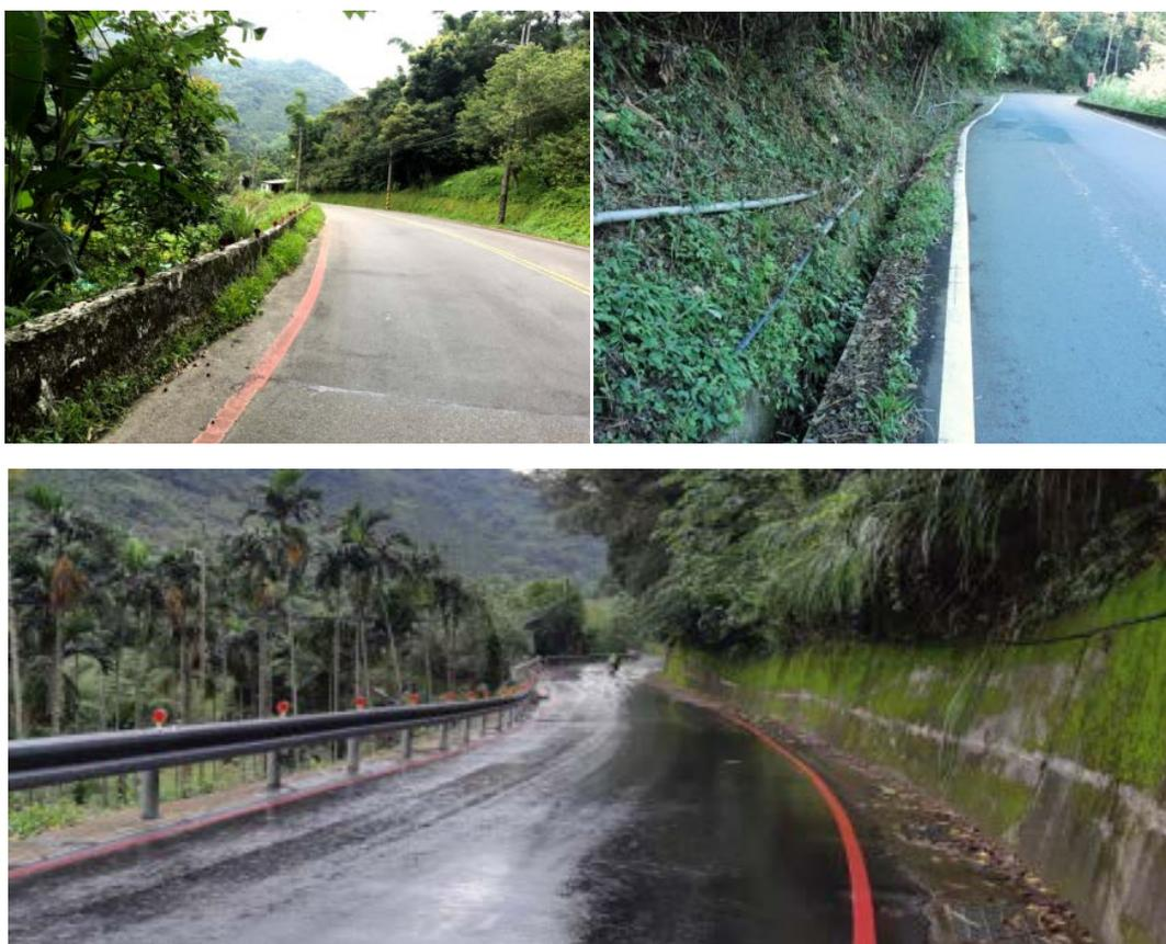
圖 2.1-2 山區道路邊坡坡度大，多混凝土工程，如擋土牆、護欄、排水溝
