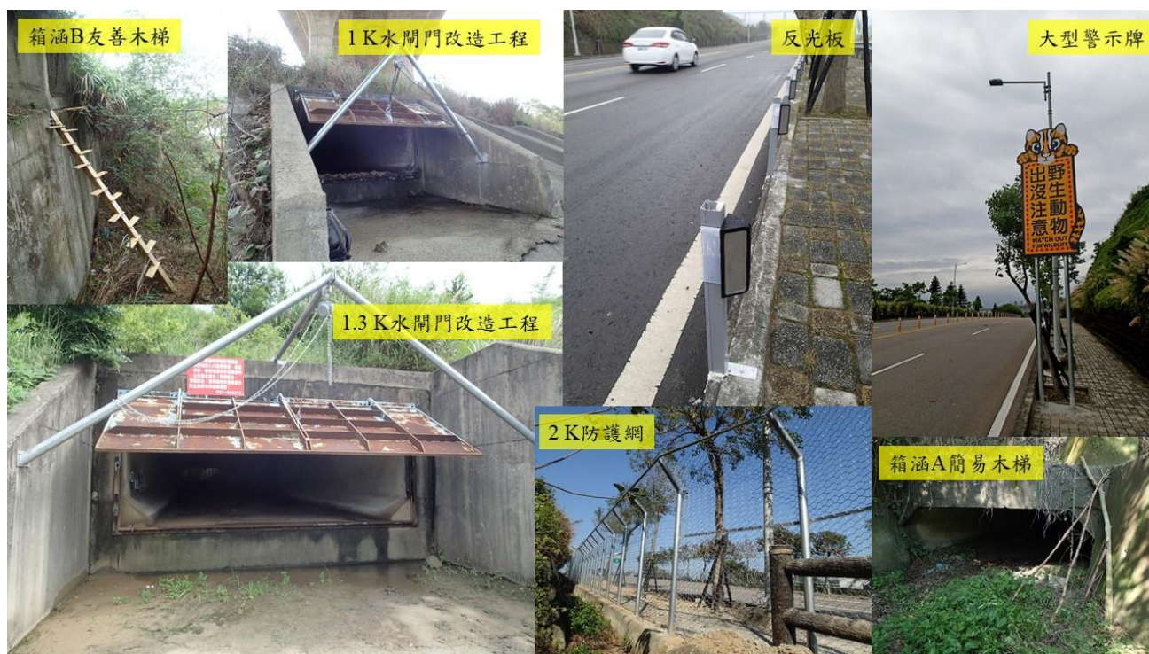
圖 4、苗 29 目前各項友善道路工程現場照片
