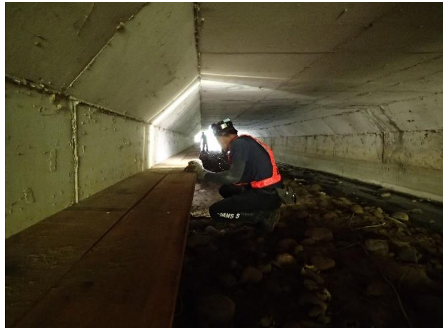
圖 32、箱涵 A 懸浮棧道架設工作照(架設)
