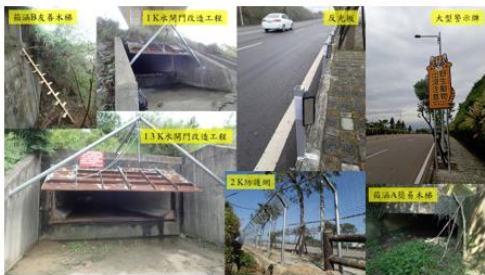
苗栗 29 鄉道友善石虎道路相關工程 42
