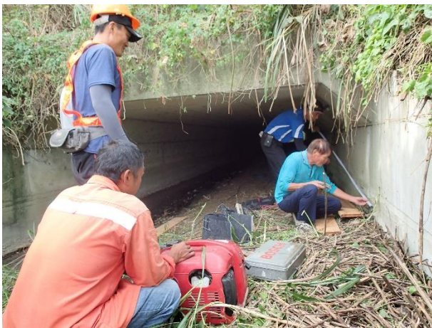
圖 31、箱涵 A 懸浮棧道架設工作照(量測)
