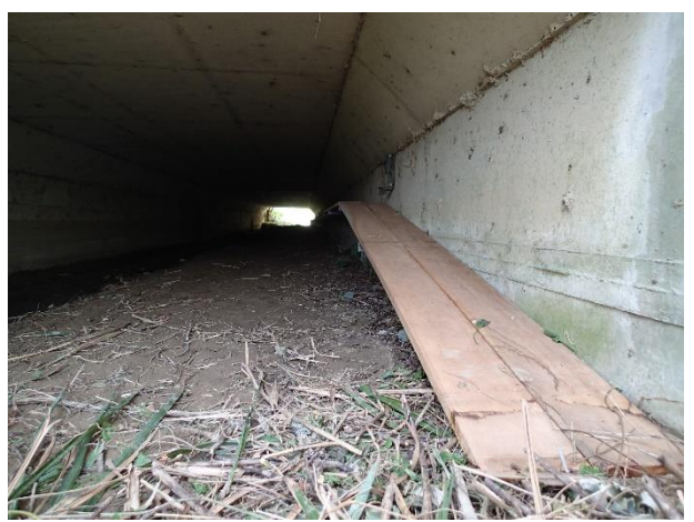
圖 32、箱涵 A 懸浮棧道架設工作照(架設)
