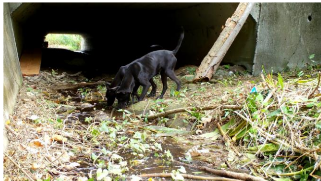
圖 41、改善設施完成後犬隻於箱涵 A 活動頻繁
