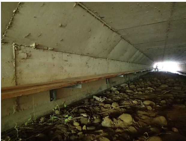
圖 31、箱涵 A 懸浮棧道架設工作照(量測)
