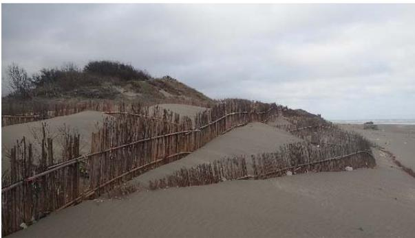
圖 6-2- 4 剖線 A 沙丘上的固沙籬
