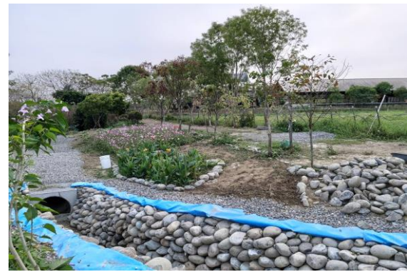
濕地經營管理—砌石固坡、橋面間隙補強
