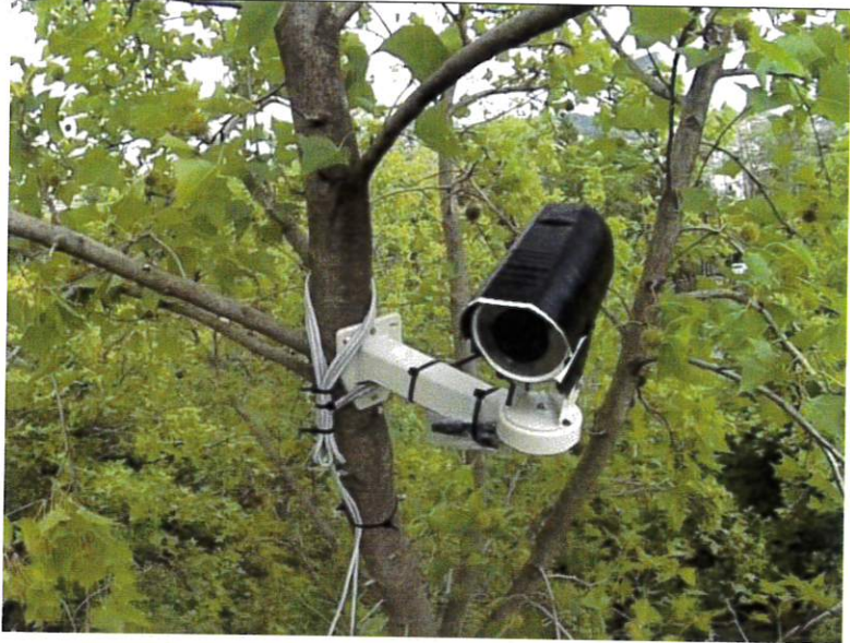
架設影像監視設 備於鄰近巢位的 喬木
