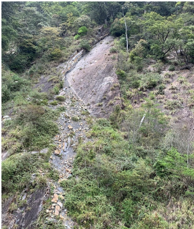
圖 31、河床上裸露的岩壁
