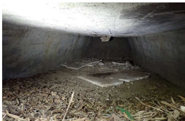
人員掩體內部，中間地面有蝙蝠排遺。
