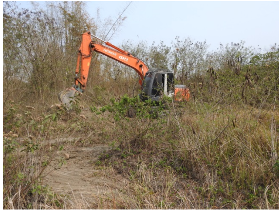
3/21 燕巢主棲地挖土機整地
