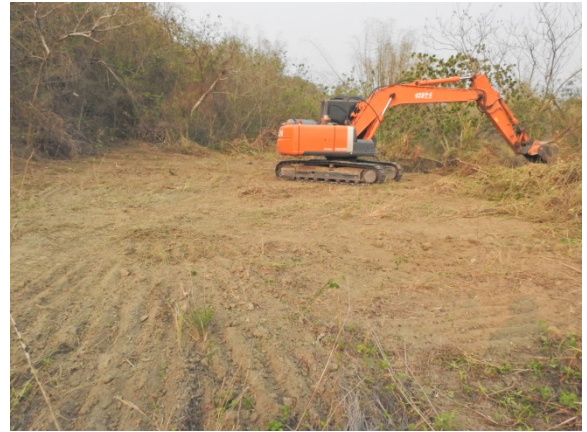
3/21 燕巢主棲地挖土機整地
