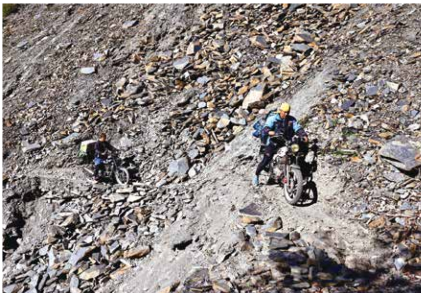
雨季過後，丹大林道常有十幾處的崩塌地段
