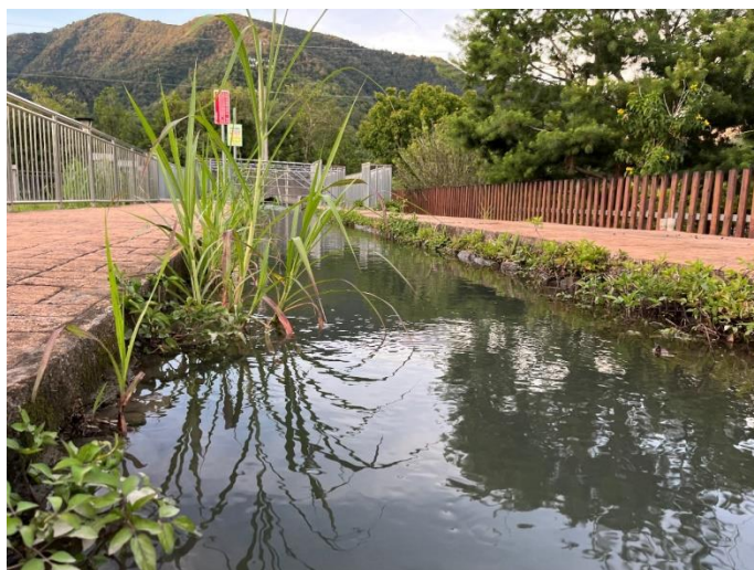
照片 5、能高大圳東幹線（眉溪）。
