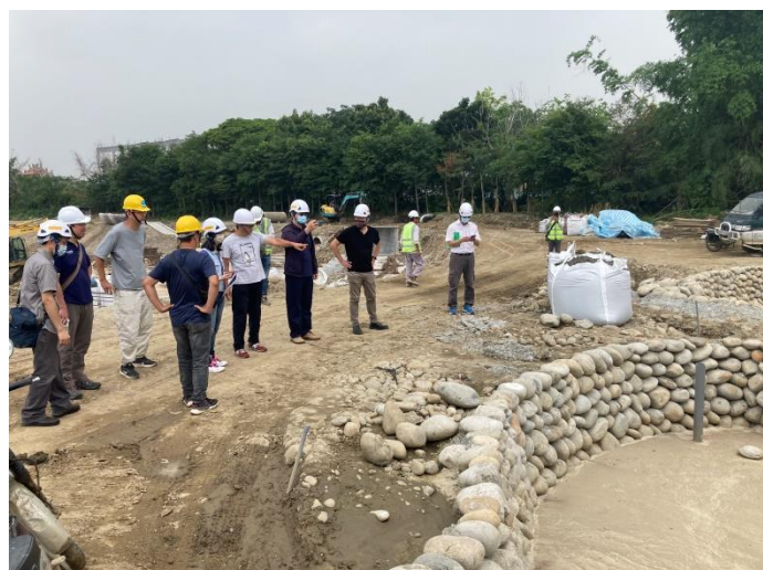
照片 6、旱溪排水生態池現勘（2023/5/26）。
