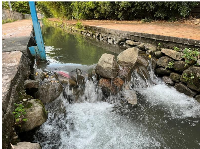
照片 4、能高大圳東幹線（眉溪）。
