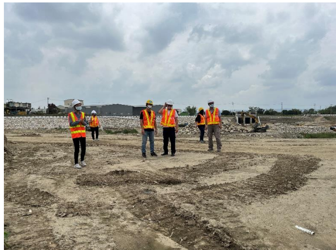
照片 4、旱溪排水生態池現勘（2023/4/6）。
