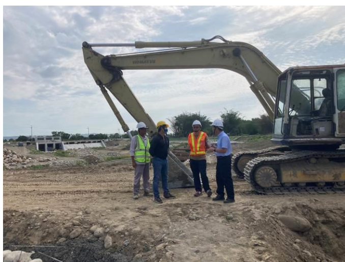
照片 5、旱溪排水生態池現勘（2023/5/5）。
