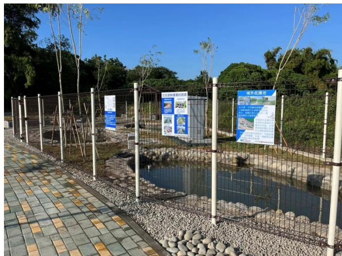
照片 8、旱溪排水生態池已完成注水（2023/10/11）。
