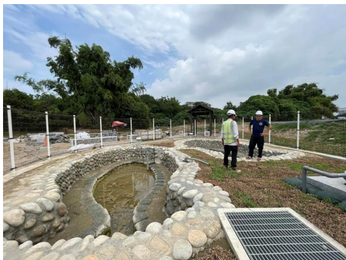
照片 7、旱溪排水生態池已完成圍籬搭設與水池管線搭建（2023/9/28）。
