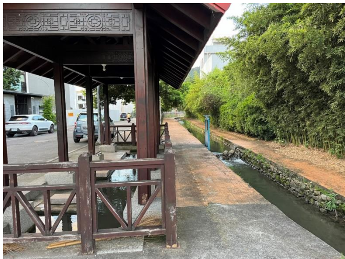
照片 6、能高大圳東幹線（眉溪）。
