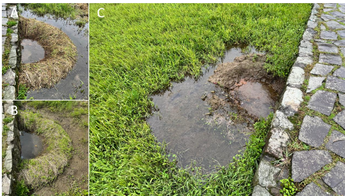
圖 25：維持濕地水位並確保赤腹游蛇活動無虞之土堤設置（A 設置一個月後； B 設置兩個月後；C 降雨後發揮濕地水位維持功能）
