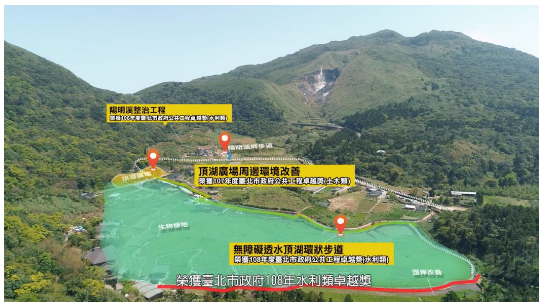
圖 12：對於瀕危物種赤腹游蛇重要棲地執行各項非必要整治的地方政府工程單位（圖片來源：臺北市大地工程處宣傳影片）
