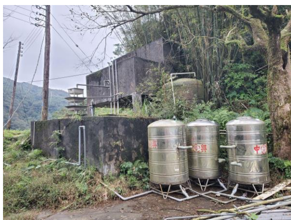
完成水塔架設及管線配置
