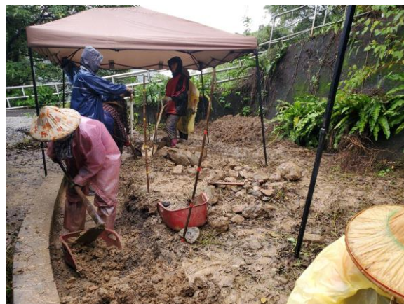
將泥土依照設計圖疊出坡度
