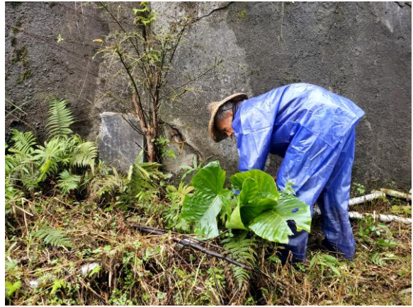
儲水槽滲漏處修補及重新洗洞
