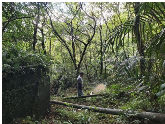
水管管線檢修及配管
