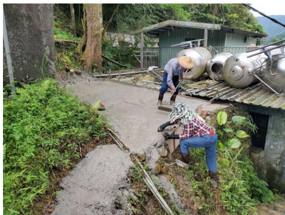
水塔架設平台灌漿及泥作施作
