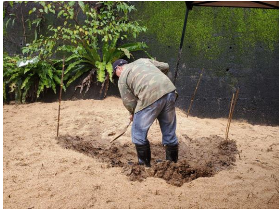
挖設濕生植物所需的水池棲地
