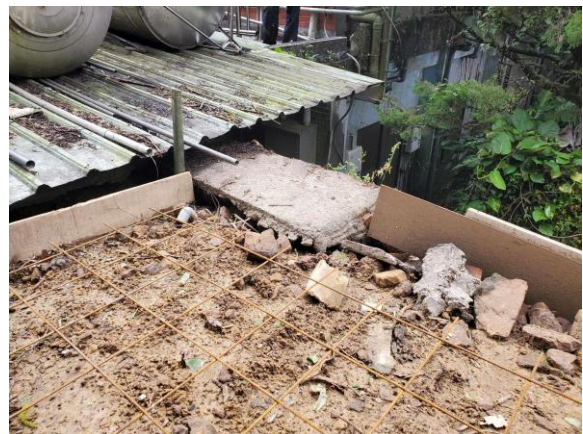
水塔基座電焊網鋪設及板模架設
