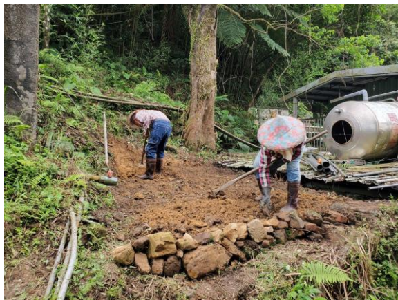
水塔基座基地整地及舊管線清
