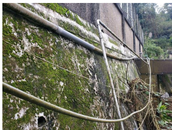
澆灌用水颱風斷裂搶修
