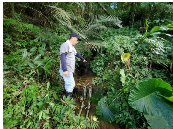
水源頭蓄水槽及管線巡護
