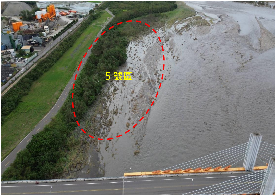
圖 13、溪尾大橋 5 號區於凱米颱風後之狀況(2024.07.27 拍攝)
