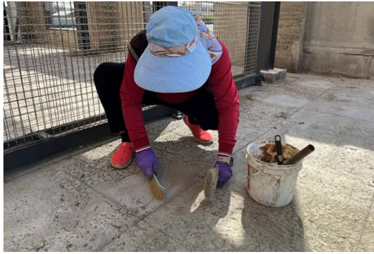
▲在鋪設木地板水泥墩座前，先在預計鋪設位置進行地面清理工作；原先既有地面以鋼刷與毛刷清理沙土，泥地面則挖洞。確保沾上水泥磚與地面的附著穩固。
