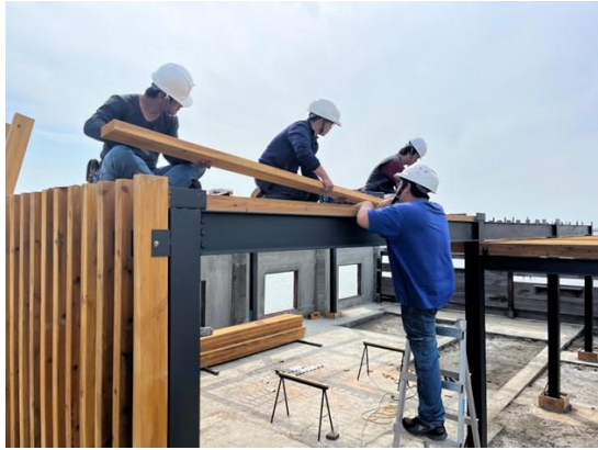
▲頂層木桁架安裝及護木漆塗佈。
