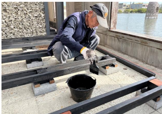
▲木地板結構第一層角料安裝後，師傅於木頭切面塗上柏油加以保護。
