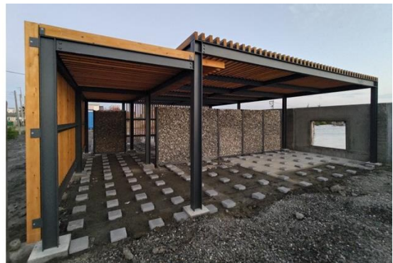
▲於挖洞之泥土面及清理後的地面填上水泥以固定水泥墩座，右上圖為水泥墩座工程完成照。
