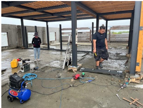
▲安裝蚵殼牆 H 型鋼及鐵絲網。
