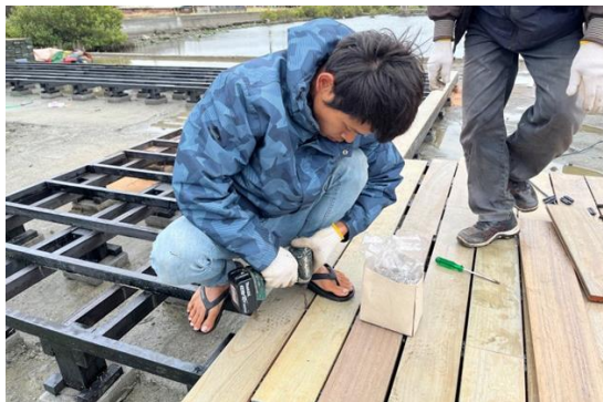
▲鋪設木地板面，師傅利用蝴蝶扣為主、螺絲為輔以固定板面。
