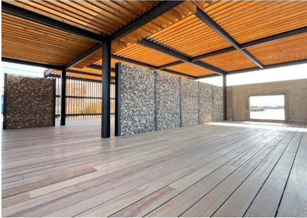
▲賞鳥亭施工完成照。
