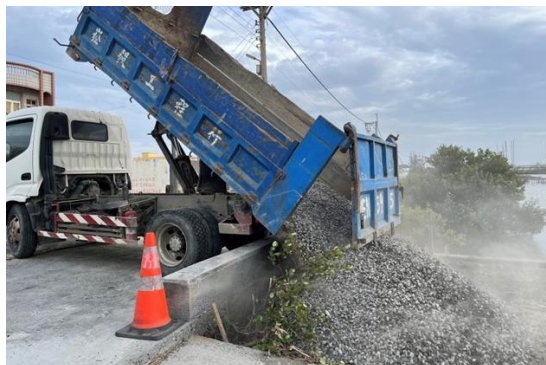
▲碎石進場及鋪設平整。
