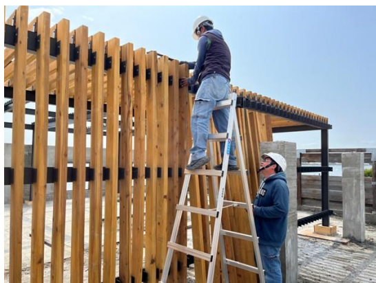
▲木桁架安裝作業。
