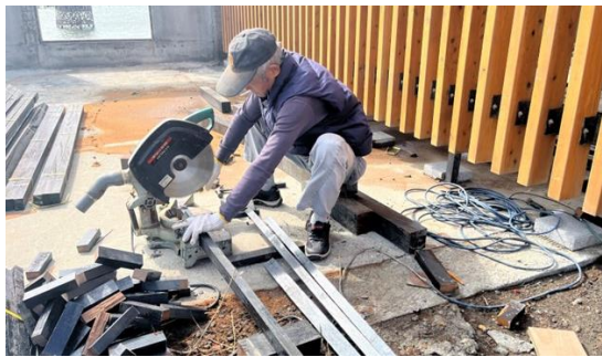
▲木地板結構第一層角料安裝，同步進行鋸木與安裝作業。
