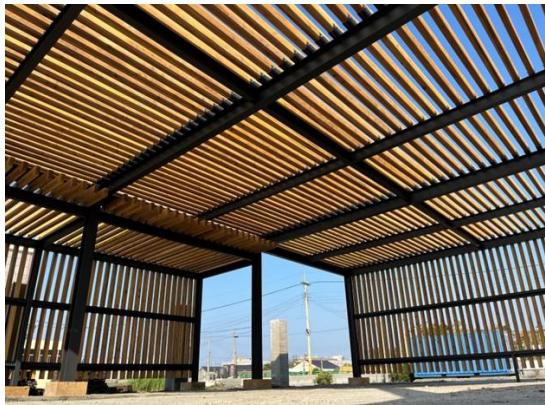
▲木格柵工程完成照。
