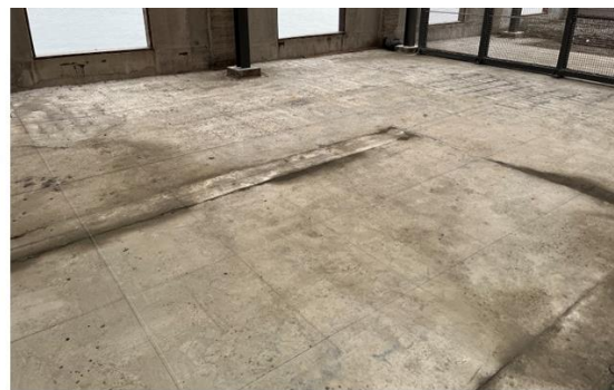
▲現場丈量並進行放樣工作，右上圖地面墨線標記為放樣之距離、格線。
