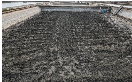
▲第一池由於缺乏讓重機具進入的斜坡，僅能倚賴小型的中耕機翻土。
