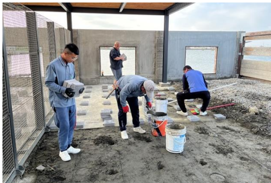
▲於挖洞之泥土面及清理後的地面填上水泥以固定水泥墩座，右上圖為水泥墩座工程完成照。
