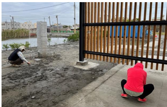
▲現場丈量並進行放樣工作，右上圖地面墨線標記為放樣之距離、格線。
