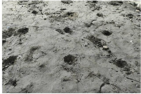
▲在鋪設木地板水泥墩座前，先在預計鋪設位置進行地面清理工作；原先既有地面以鋼刷與毛刷清理沙土，泥地面則挖洞。確保沾上水泥磚與地面的附著穩固。
