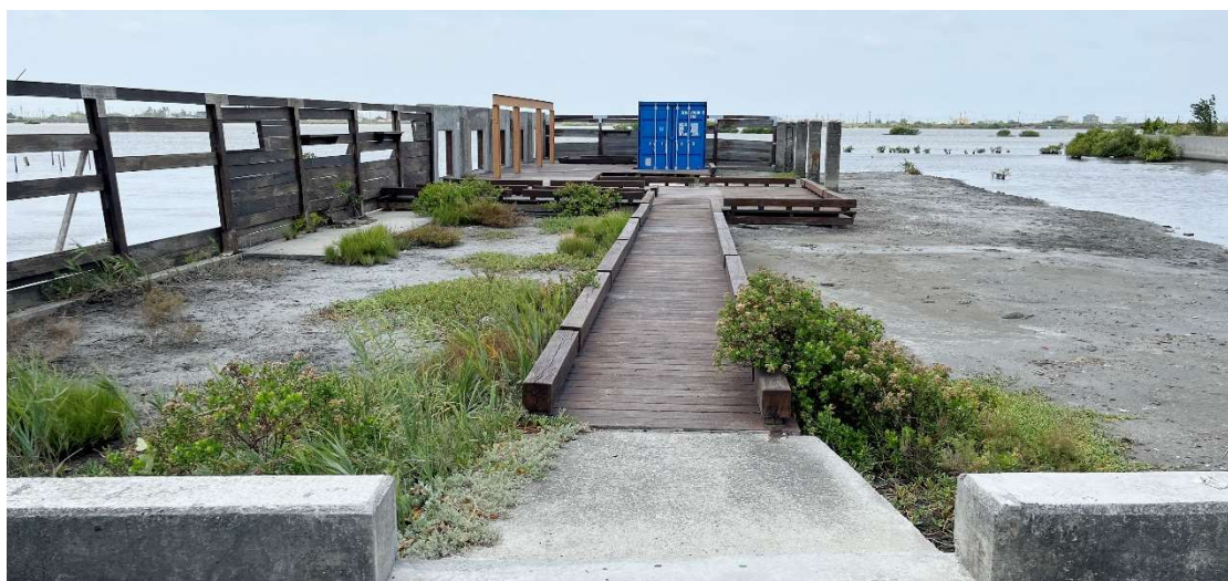
▲基地動工前現場照片
