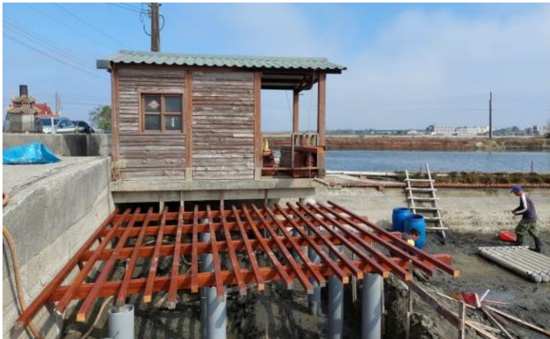
▲今年度完成木平台的結構施作。
