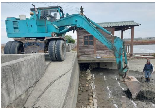
▲利用挖土機整地、移除大石塊，並挖出木平台的地基範圍。
