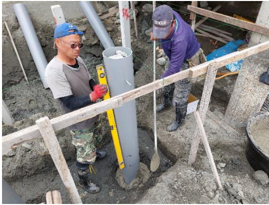
▲將塑膠管套在水泥柱外面，塑膠管能保護內部的水泥柱免受海水侵蝕。塑膠管上部加裝不鏽鋼螺絲用來固定木樑。
