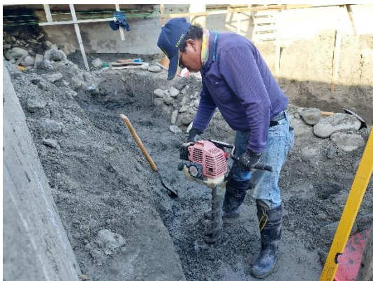
▲在柱子要放置的位置利用鑽地機鑽洞，再用長柄尖鏟挖土擴孔。
