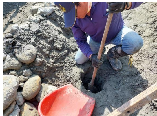
▲在柱子要放置的位置利用鑽地機鑽洞，再用長柄尖鏟挖土擴孔。
