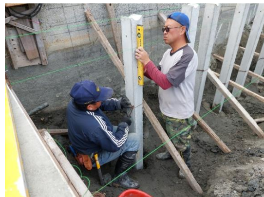
▲利用吊臂將水泥柱放入柱洞中，位置校正後於柱基倒入水泥漿將其固定。
