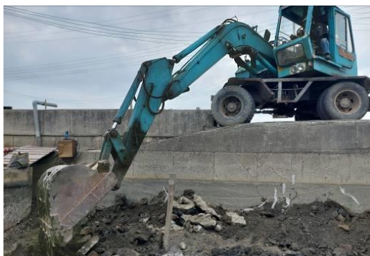
▲利用挖土機整地、移除大石塊，並挖出木平台的地基範圍。
