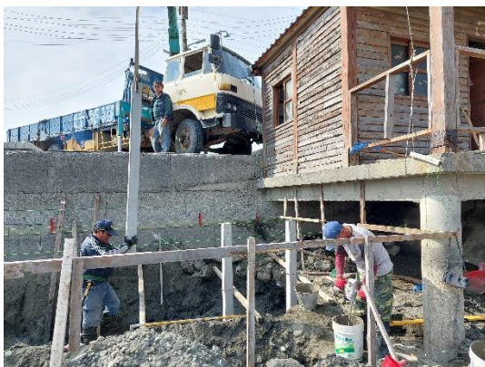
▲利用吊臂將水泥柱放入柱洞中，位置校正後於柱基倒入水泥漿將其固定。
