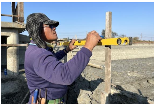
▲拉水線標示出水泥柱的平面及柱子要放置的位置。
