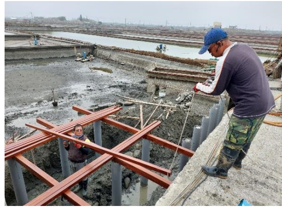
▲將木樑固定在水泥柱上，主樑之上還有副樑支撐起木平台的結構。
