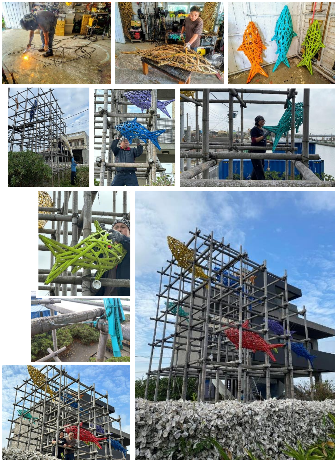
▲「魚光點點」如魚群穿梭礁岩中，生動且鮮豔。每尾魚皆由鋼筋銲接而成的骨架為基礎，外覆竹編，再以油漆上色，在原色的竹架間非常搶眼。考量到安全性及穩定性，皆以纜線及不銹鋼絲固定。
