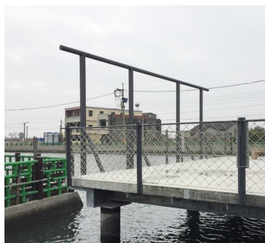
遮陽網立柱鐵件工程 - 完工照
