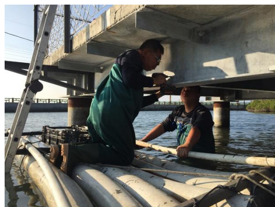
在平台基座 H 型鋼引洞
