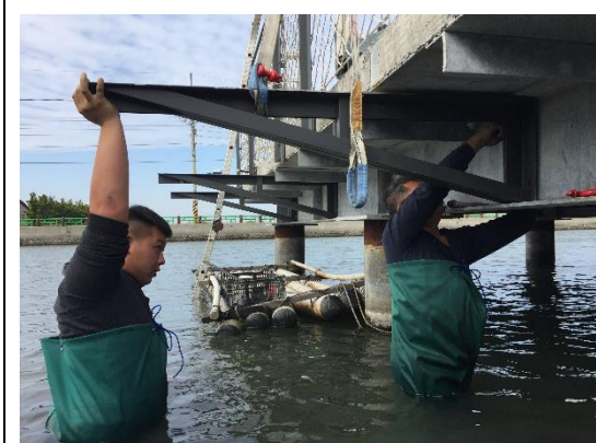
以螺絲將三角架固定於 H 型鋼
