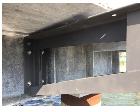
以螺絲將三角架固定於 H 型鋼
