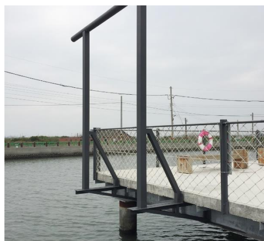
遮陽網立柱鐵件工程 - 完工照
