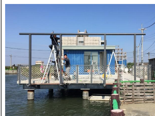
確認橫桿與立柱圓弧凹槽的密合度
