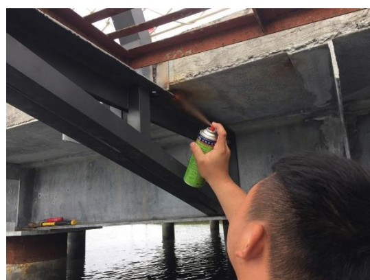
刷洗焊接處表面，再補紅丹漆
