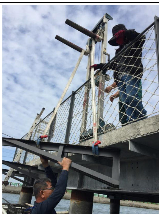
利用堆高機從平台吊掛三角架
