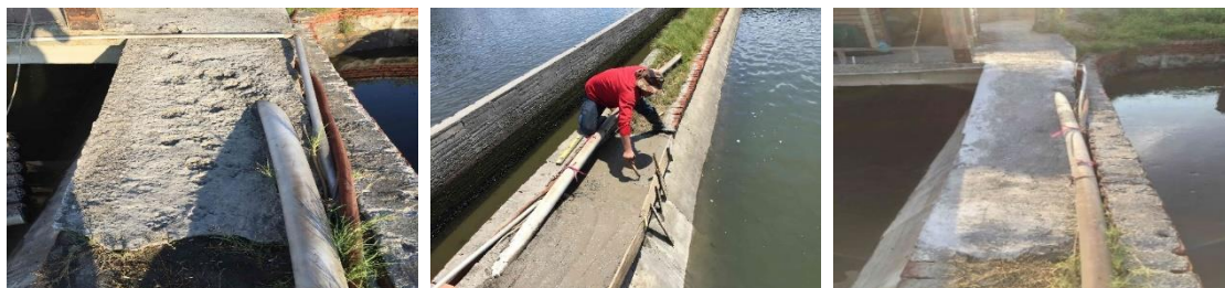
▲斜坡道表面凹凸不平，將其打掉重鋪。
