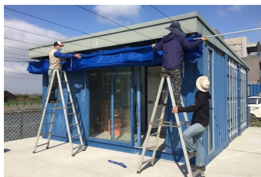
遮陽網穿入拉桿並固定
