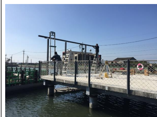
用堆高機協助抬升 7.5 米橫桿
