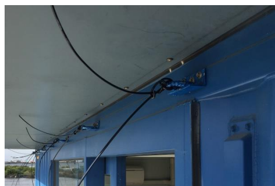
安裝起點吊環、綁塑鋼繩
