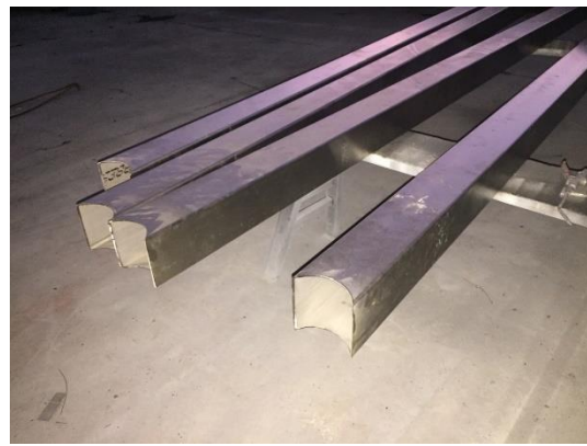
4 支立柱鴨嘴加工（圓弧凹槽）
