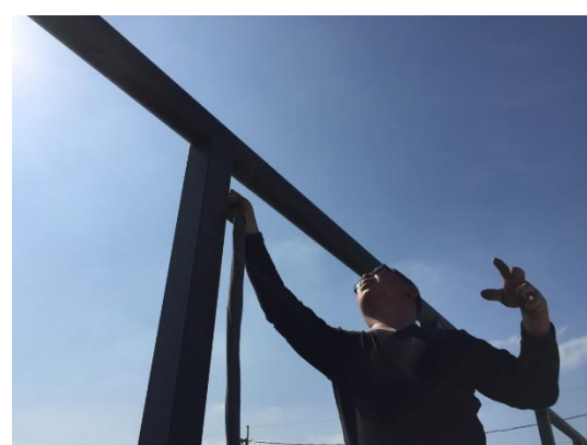
滿焊立柱圓弧凹槽
