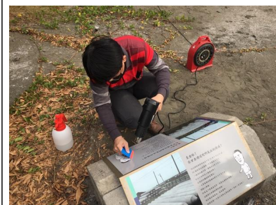
使用刮板、熱風機加強輸出密合度
