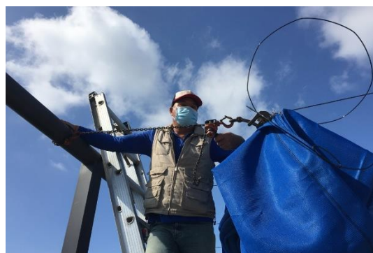
利用吊猴拉緊塑鋼繩
