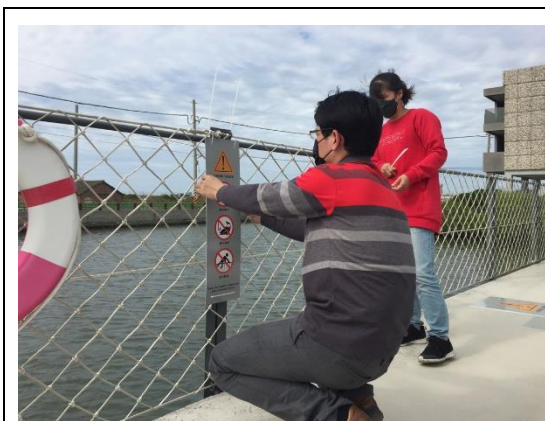
使用束帶將安全告示牌固定於欄杆立柱
