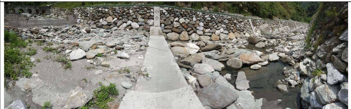
出谷處的固床工 + 鼎塊落差側視，落差坡上棲地基質良好。
