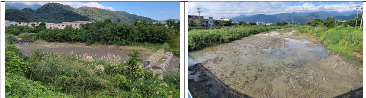
宜 3-1 縣道以東的坡地段，連續固床工間常態斷流。頭城鎮區平原段定期有機具疏通。
