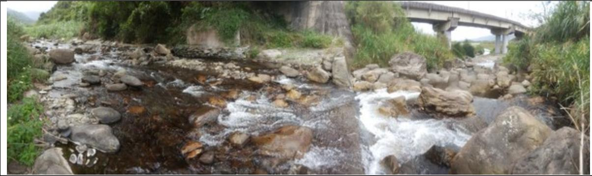
出谷處的固床工 + 鼎塊落差側視，落差坡上棲地基質良好。
