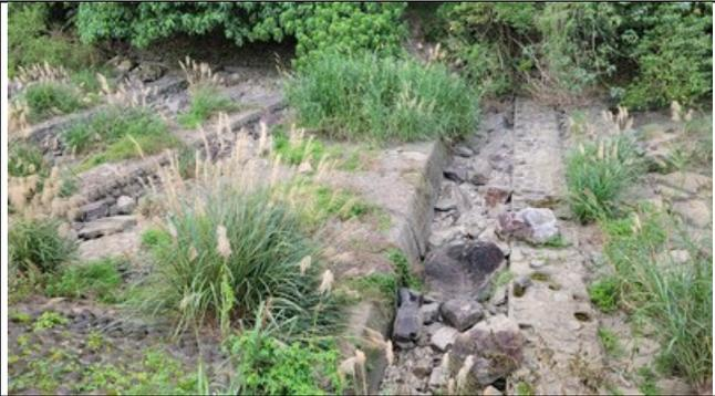
上游取水口下的連續壩體，及取水量，使此段幾乎全年斷流，僅大雨後短時間有水。
