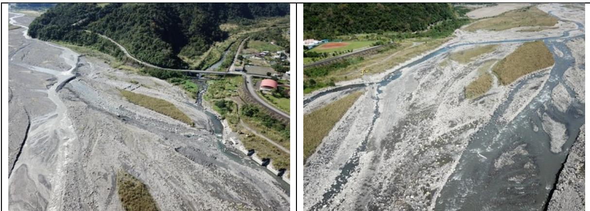
河道工程常沿主流溪岸加強防護，施工過程或結果，常阻斷近岸辮流與支流的連結度。
