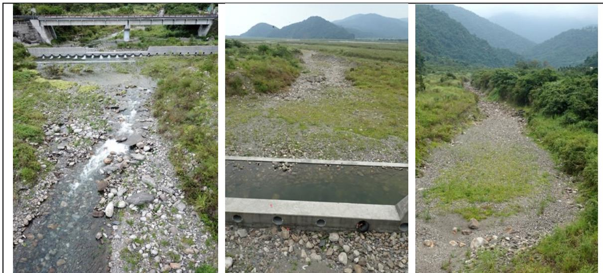
松羅溪出谷新設了防砂壩，持續抬高河床，拉長枯水期伏流距離，豐水期的阻隔程度不明。
