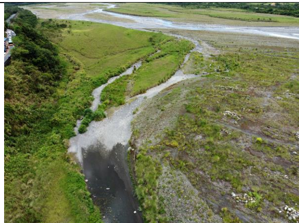
( 左 ) 延長的匯流端 1/30 水勢平緩部分流動於草澤下，( 右 ) 202208 枯水期出現地表斷流
