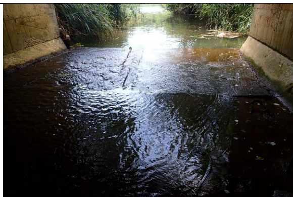
（左）雙溪河匯流口的植生應予以保護，學苑街交會處橋基的平坦三面光並有明顯落差，大部分偏好下游的大型掠食種都被阻絕於下方。
