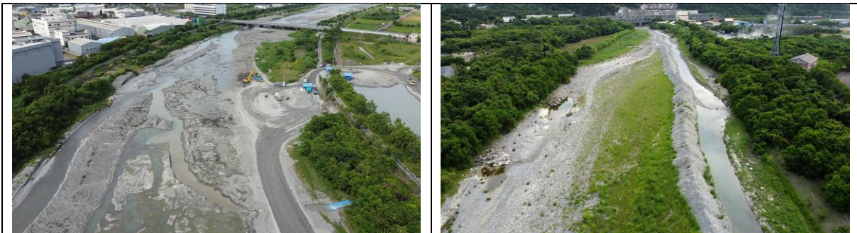
2021/08 疏濬前期，可見作業方式先圍土石堤導水，再全斷面浚深，土石方直接在堤外回填使用，因而取砂量不大。
