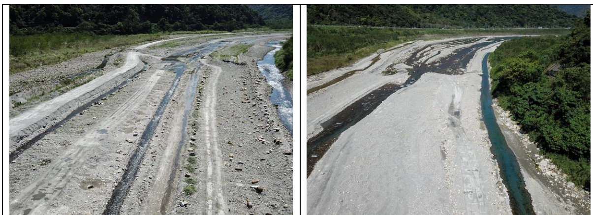
2022 年 3 月，撤場後的第一個冬雨期結束，集中流路、浚降河槽、施工便道形成三層截然分明的高程差；一直到 10 月才有局部的恢復。
