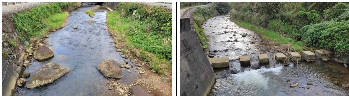
2023/1/8 再次經過冬雨季後的狀況，低灘地全部沖開。顯示低灘地的草叢作為調節集中流路的功能，並不妨礙大水來時的通洪斷面，只要維持低灘地有小於一年的洪水溢淹頻率。
