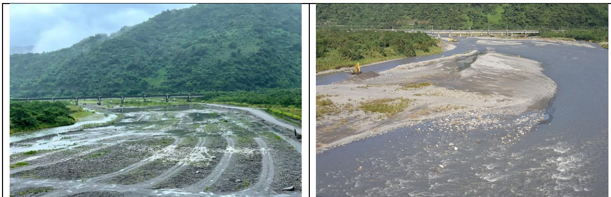
2021 年（左）6 月，鐵路橋下游斷的疏濬狀況。（右）10 月曾有圓規颱風外環共伴東北季風的大雨，上游翠峰湖雨量站 3 日 1,068mm 的雨量，而曾有一次局部恢復流路的連結，但施工單位隨即圍堤阻絕。
