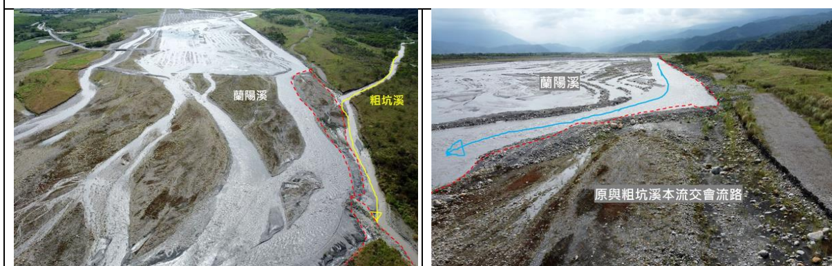
疏濬邊界殘留的高灘地，及略上游的圍堵，迫使蘭陽溪主流路與粗坑溪隔開。
