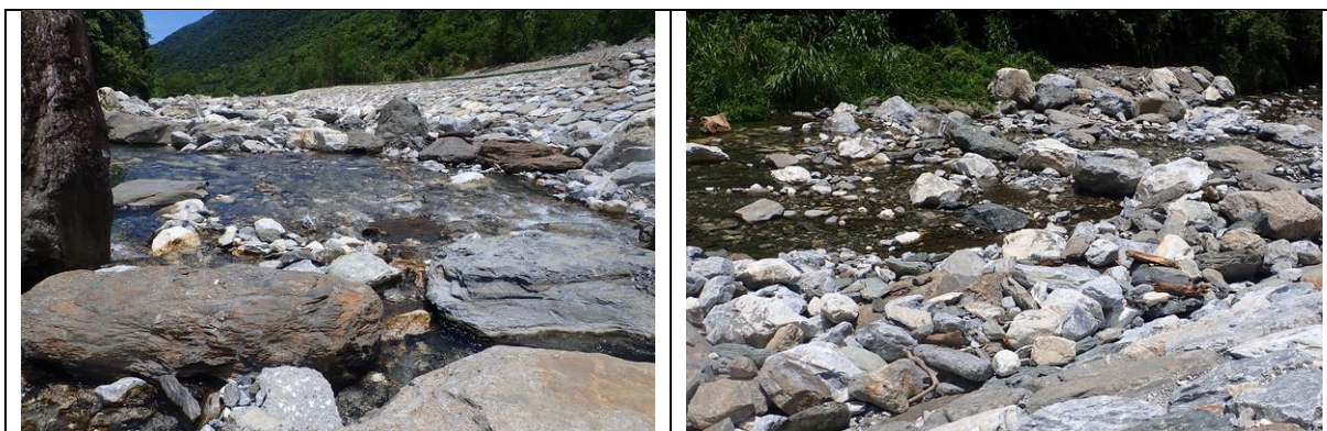
枯水前期一期工程改善後的漿砌固床工沒有明顯阻隔，但低水流路也不集中。
