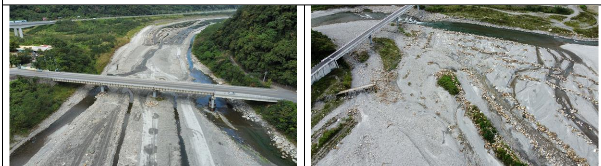
2022 年 1 月疏濬撤場不久的狀況：（左）疏濬下端的澳尾橋段，導水路維持在兩側，河道中間 2-3 條施工便道明顯高於兩側。（右）疏濬上端的哈卡巴里斯橋原本大轉彎的扇狀流路也仍維持著施工後集中於轉彎外側的深槽，無效料堆在原扇狀流的灘地上，並冒出銀合歡。
