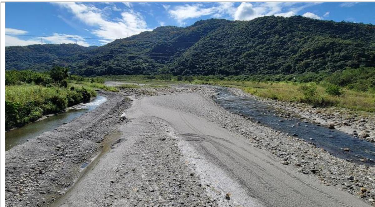
12 月雨量漸少，月底鄉公所再次補圍堤導水，但仍保持有部分斷沒有有圍堤，只向上游延伸的作法（上），因此取水之後仍有部分流量保留在沙韻橋下游的自然河道內（下）。
