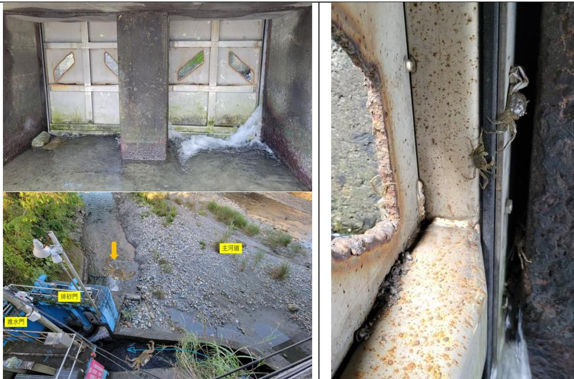
冬山圳分流到林吉記圳林寶春圳前的排砂溢水門，(左上) 先進行切口，當生物能通過溢水門，將沿著長度約 65m 的引流道回到武荖坑溪主河道 (左下)。
