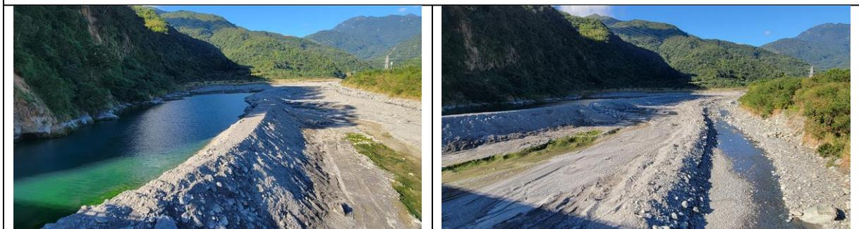
(左) 射馬干圳取水圍堤的取水量比例高，若側面設置溢流口，則能放回不需要的流量至(右) 利嘉溪主流路。
