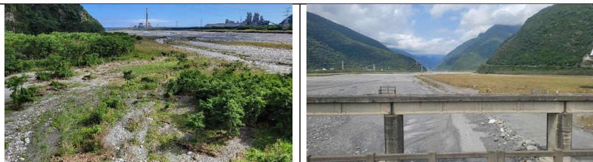
(左) 202211 豪雨過後楓溪下游雖把擴張的林木沖開，但河道高程仍明顯高於匯流端。因而也提早使匯流前流速減緩搬運能力變弱，進一步堆積了形成阻礙自然流路的量體。因此前述疏濬建議中，至少在有支流匯入的斷面，合理流路線型區域應同步適當濬深，包含「支流匯流流路+主流趨近匯口的辦流」。 (右) 202303 疏濬開始時，沿用前期便道。
