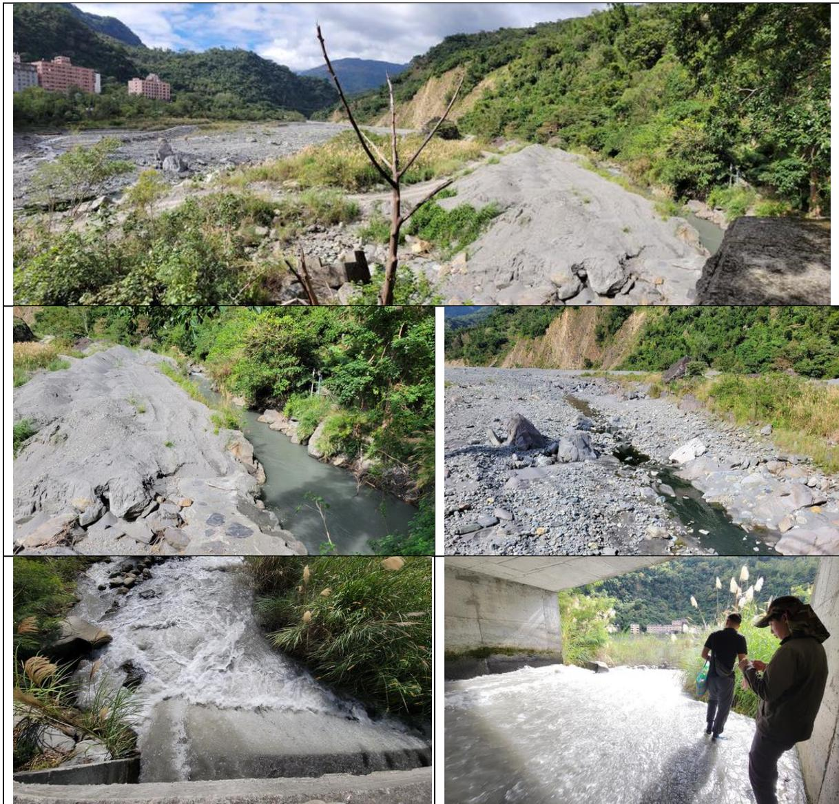
(上) 知本圳入流引水道，導水土堤延長近 900m，取走大部分流量。
