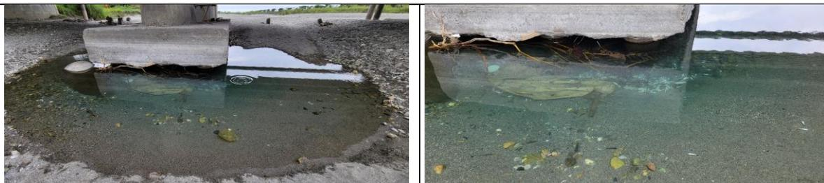
乾涸過程中，橋墩下掏刷形成的水窪。殘留的物種則兼具以上兩類型殘流水窪的種類。
