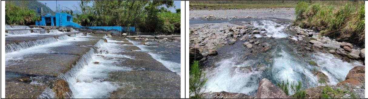
從二幹線渠首工溢流後，經過（左下）方形消波塊階梯、（右下）便道涵管，回歸南澳北溪主河道。（上）為連續視景，右側為渠首工，左側為北溪主河道。
