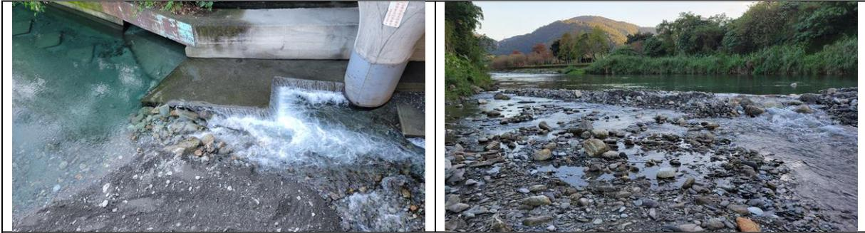
圍堰調整方式 (上) 俯視相對位置。(中) 往下游方向斜視·此時下游主河道仍有因疏濬進行中而偏左的連續水流。(下左) A 缺口=被引導後流心。(右) B 缺口。
