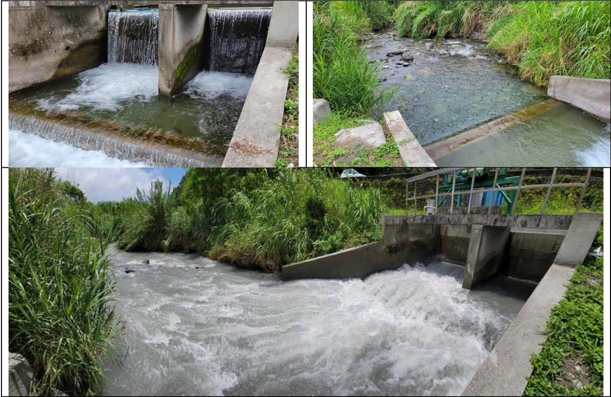
大南澳圳三幹線 (上) 制水門端引水道近年混凝土渠槽化並加設排砂門。
