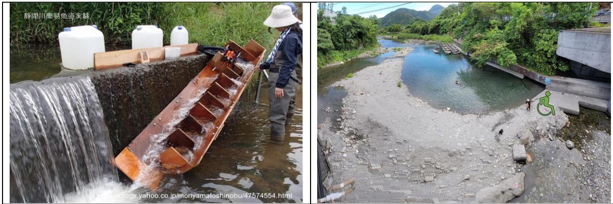
參考 ( 左 ) 靜間川魚道型態，準備於取水土堤與構造物銜接點 ( 右輪椅標誌處 ) 佈設。
