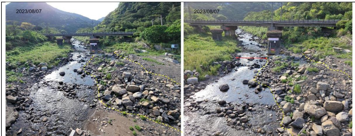
黃虛線內為水井移動時堆置的大徑石，成小洪水無法溢淹的大徑不可動質，限縮通洪斷面。
