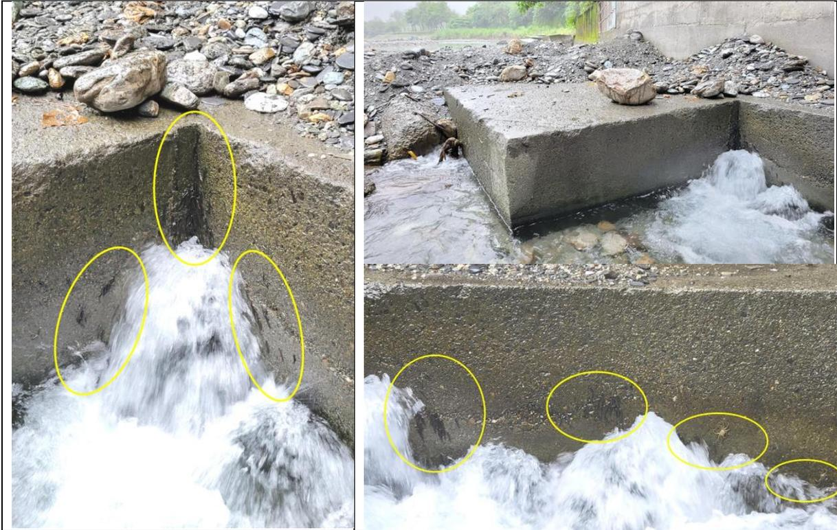
圍水土堤與結構物接點無法密合，大量溪水從下方噴湧誤導上溯個體。
