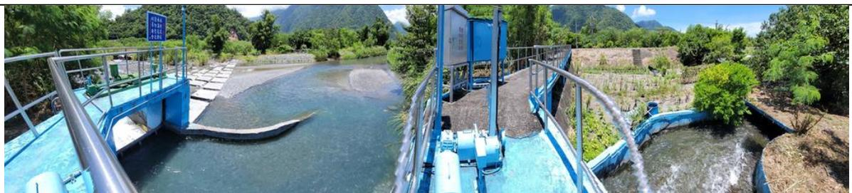
二幹線渠首工環景照片。往左側回歸北溪主河道，往右側進入二幹線渠道。
