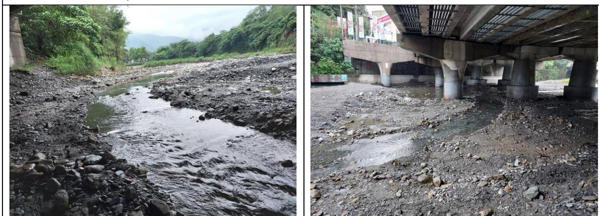
3/29 公路局處理出淺窄低水流路集中少水時的水流，並預期於降雨後可引導水流，從此流路左右拓展成自然河槽的態樣。
