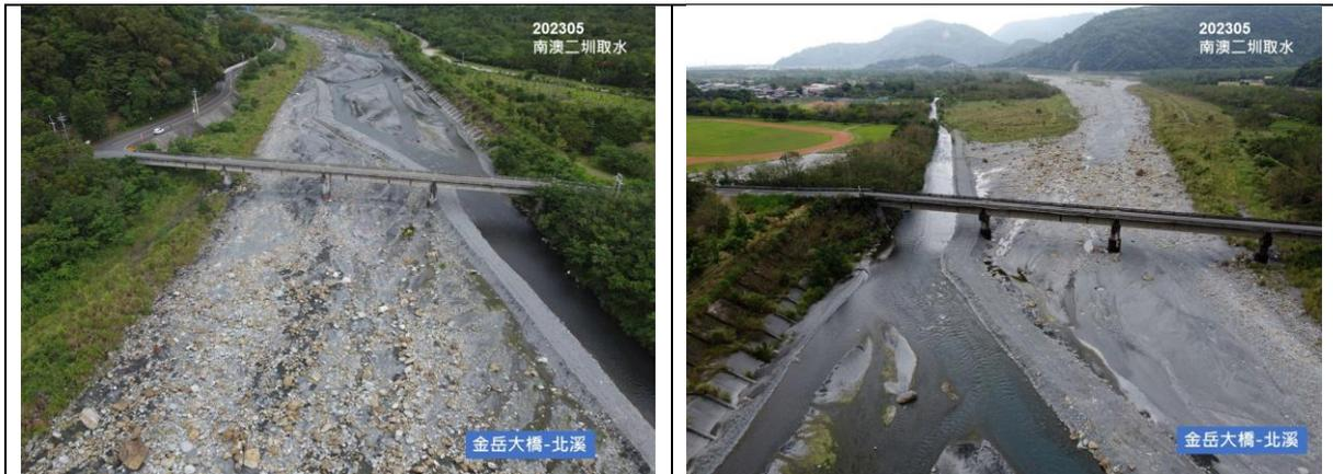
近年二幹線採全斷面引水圍堤取水，（上）造成土堤以下游至溢流口間約 1,000m 河段，包含鹿皮溪匯流口間，有近半年的乾涸。
