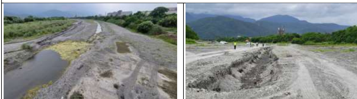
現場正供另一縣府工程取石料，原指定取法為挖掘小面積的深溝，極不利河相恢復，取料品質也不佳。
