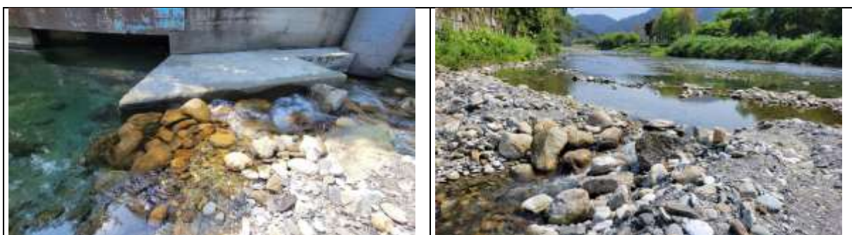
（左）今年冬山圍水土堤開口A，及（右）開口B的形式，都以較大塊石排砌成跌水瀨。
