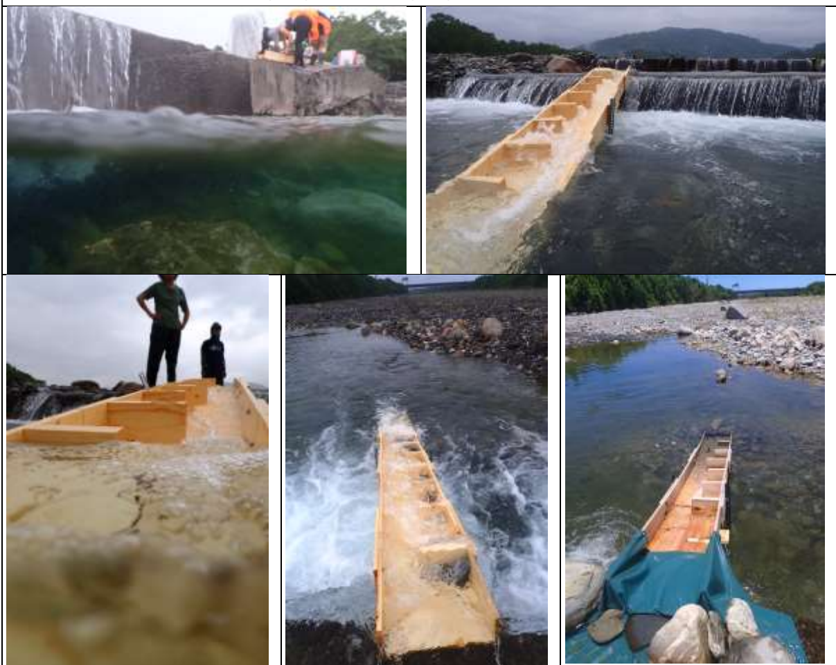
3/11 魚梯測試，5/31 魚梯架設，7/9 魚梯補強。
