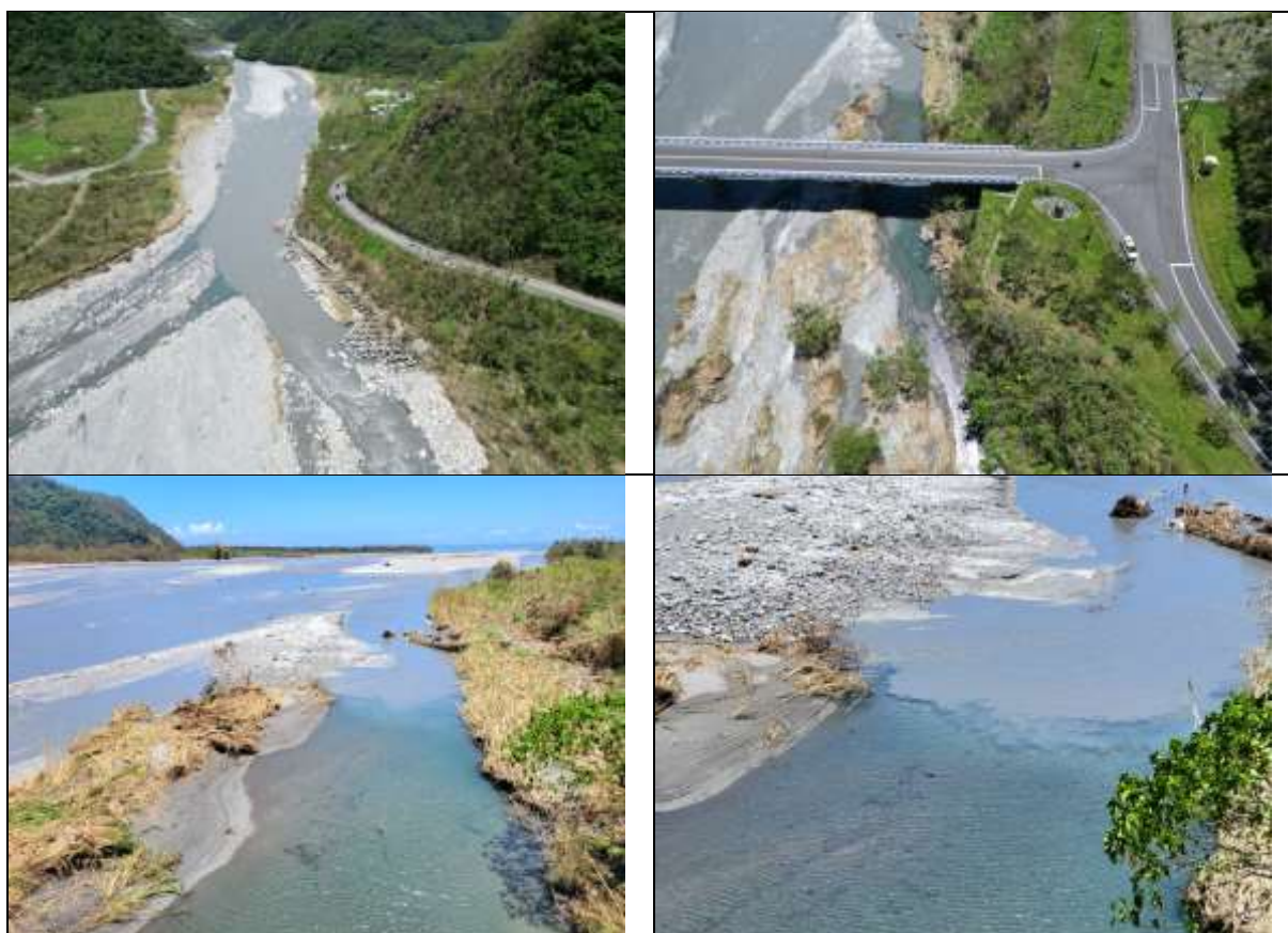
辮狀河中的次流路或其他連通水域，都在主流大濁湍急時成為庇護棲地，梯度變化應確保。 ( 左上 ) 無名溪匯流段的空拍可看出，主流的次辮比主辮清澈而緩流。( 右上/左下/右下 ) 三幹線排砂門溢流路，在主流回壅懸浮物又沉降時，清澈的環境成為大魚聚集地。
