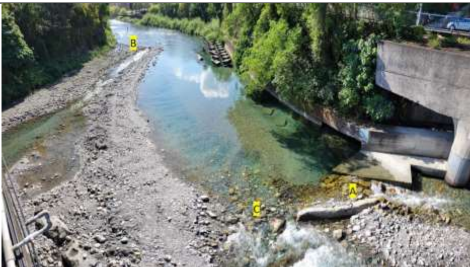
圖右之左岸藍漆混凝土構造缺口為冬山圳取水口，預設最深流路，另在土堤圍堰保留 AB 兩缺口。春雨及梅雨皆銀在流心正沖的 C 沖開缺口。
