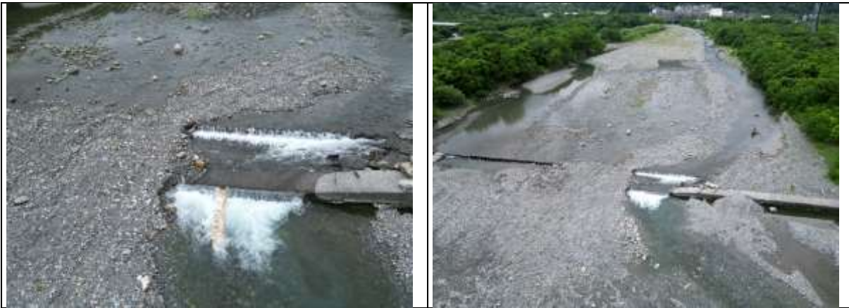
臨時魚梯在梅雨期間的束流下部分損壞，但期間可能仍具通道功能。
