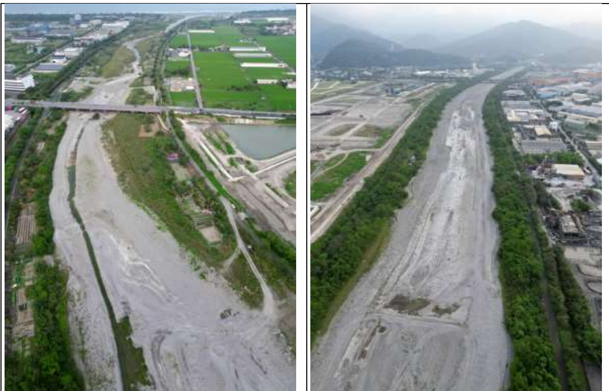
4/12 疏濬撤場時留下「溪不成溪」的狀態。(左)疏濬下端往河口方向，和龍德大橋下游高程未降而相對隆起的管制站。(右)疏濬下端往國五方向，乾涸河床僅剩平坦單調的基質。
