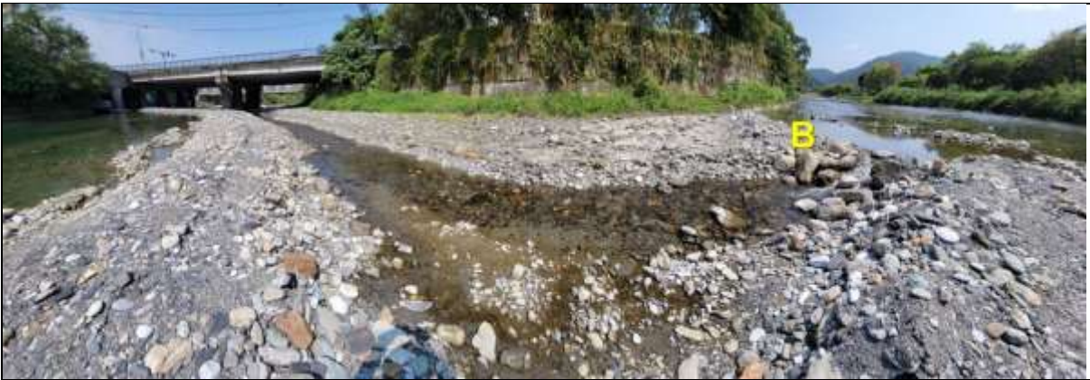
一月施作時分別在左岸 A 右岸 B 保留缺口，並以較大塊石排砌成近自然跌水路。
