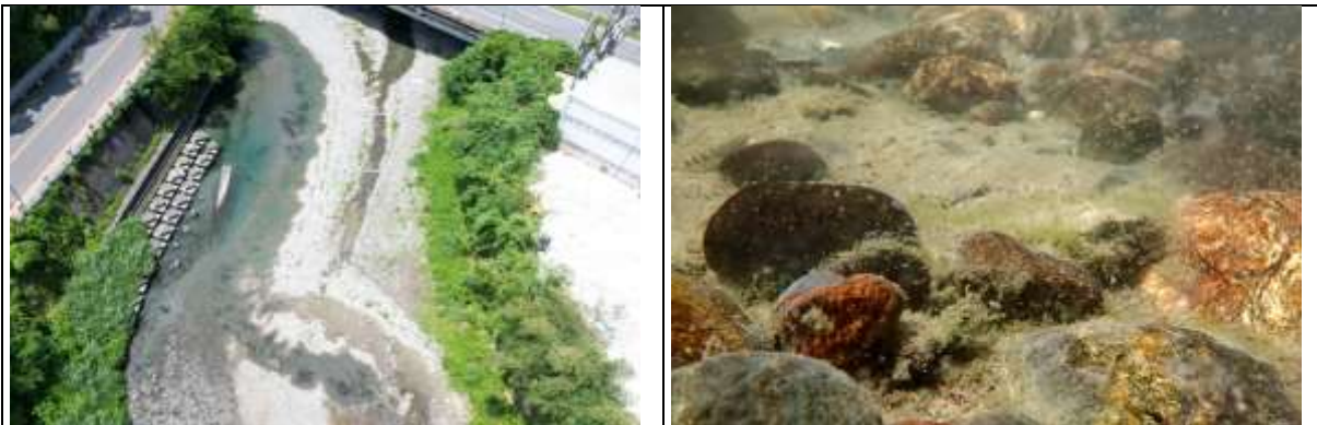
當開口周邊高程挖填混亂時，如（左）開口 B 的入流端，會導致棲地劣化，如（右）的水滯滯優養化，也失去連續水深及流量。
