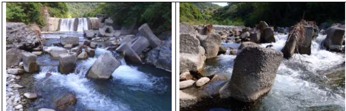
（左）東坑一號壩及（右）下方副壩，下游側歷年放置鼎塊多沒入壩下掏刷處，成為階潭的一部分。
