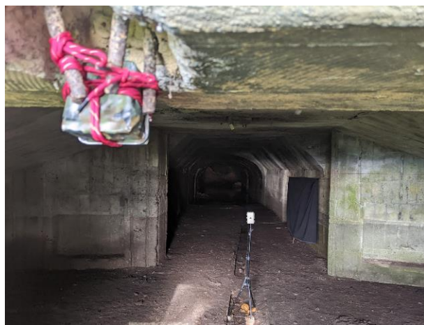
D. 架設於南48-004坑道出入口的影像紀錄器與超音波錄音器
